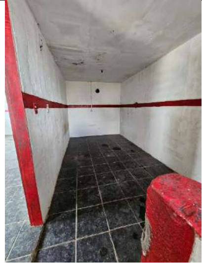
Vista sala existente
