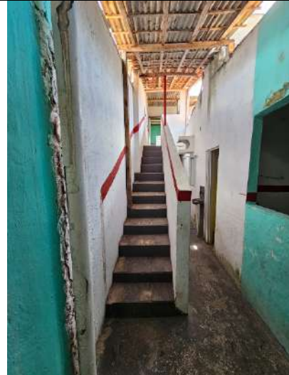
Vista de escada existente
