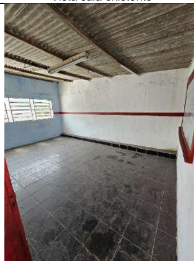
Vista sala existente
