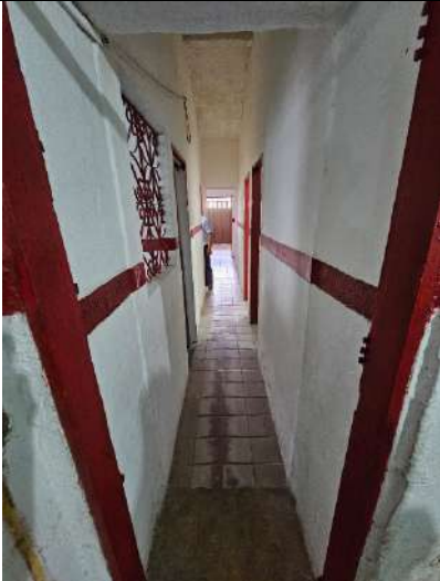
Vista corredor de entrada futura creche
