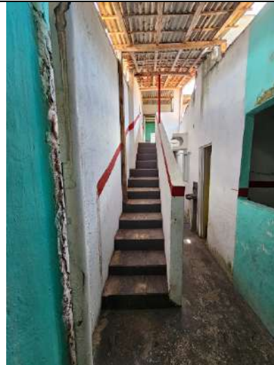
Vista de escada existente
