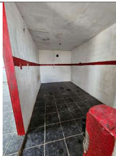
Vista sala existente
