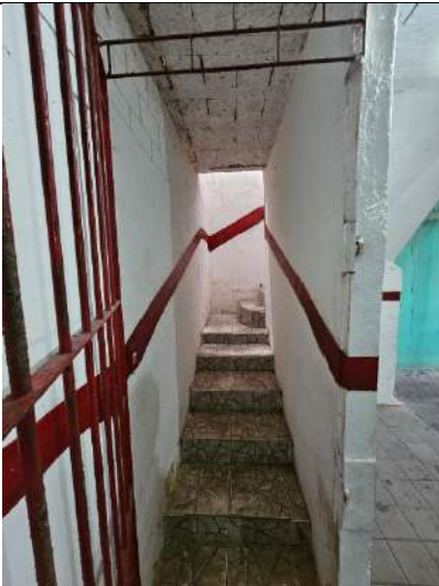
Vista de escada existente
