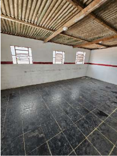
Vista de sala existente
