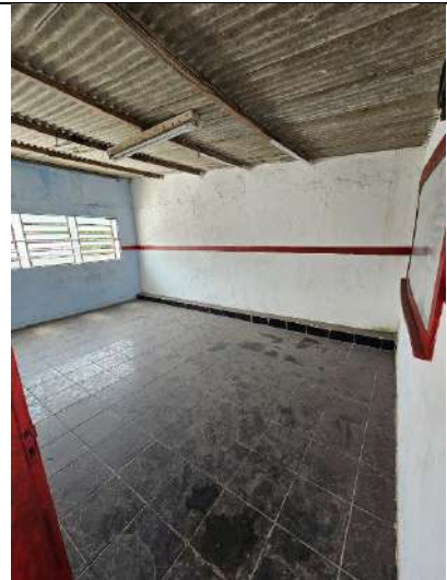
Vista sala existente
