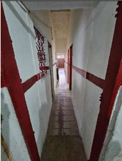
Vista corredor de entrada futura creche
