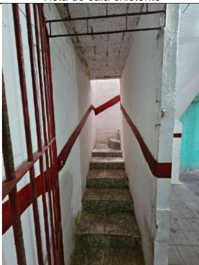
Vista de escada existente
