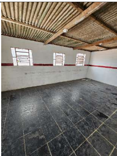
Vista de sala existente
