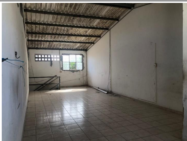
Vista subida para mezanino existente
