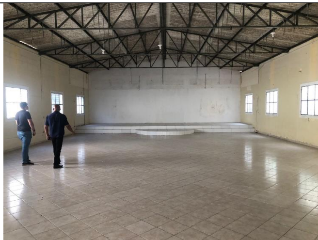
Vista interna futura creche
