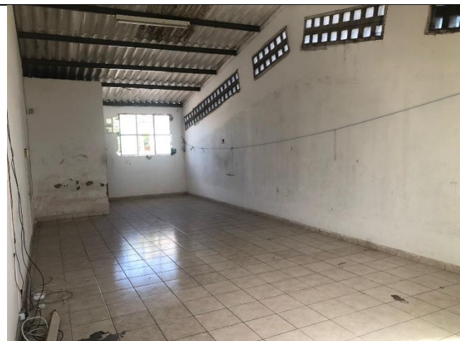
Vista subida para mezanino existente
