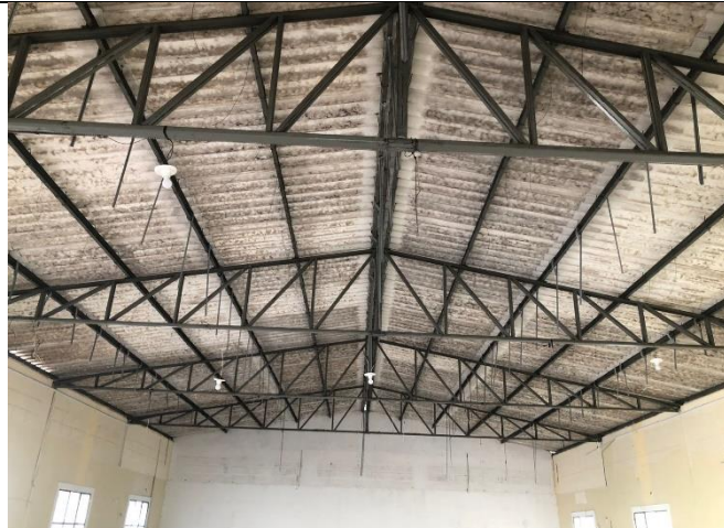
Vista coberta futura creche
