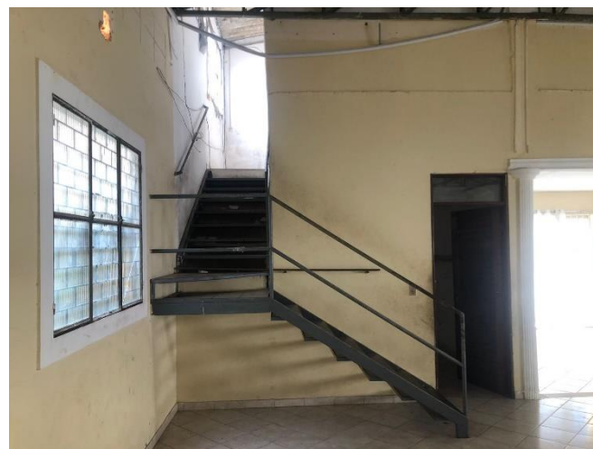
Vista subida para mezanino existente
