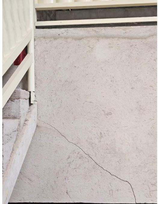
Vista fissura na estrutura existente a ser tratada
